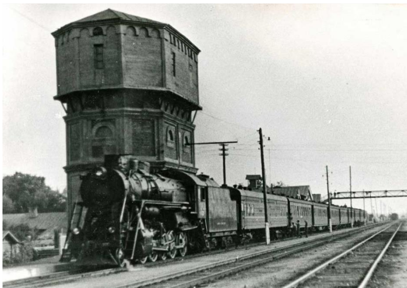
Рис. 1. Водонапорная башня станции Шуя. Фото 1968 г.
