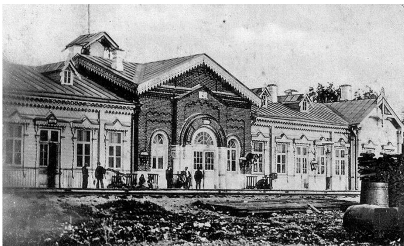
Рис. 3. Современное здание вокзала. Дореволюционное фото
